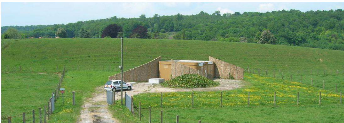
Photographie 2-2 : Site de captage du forage F10 (Fontaine-le-Bourg)
